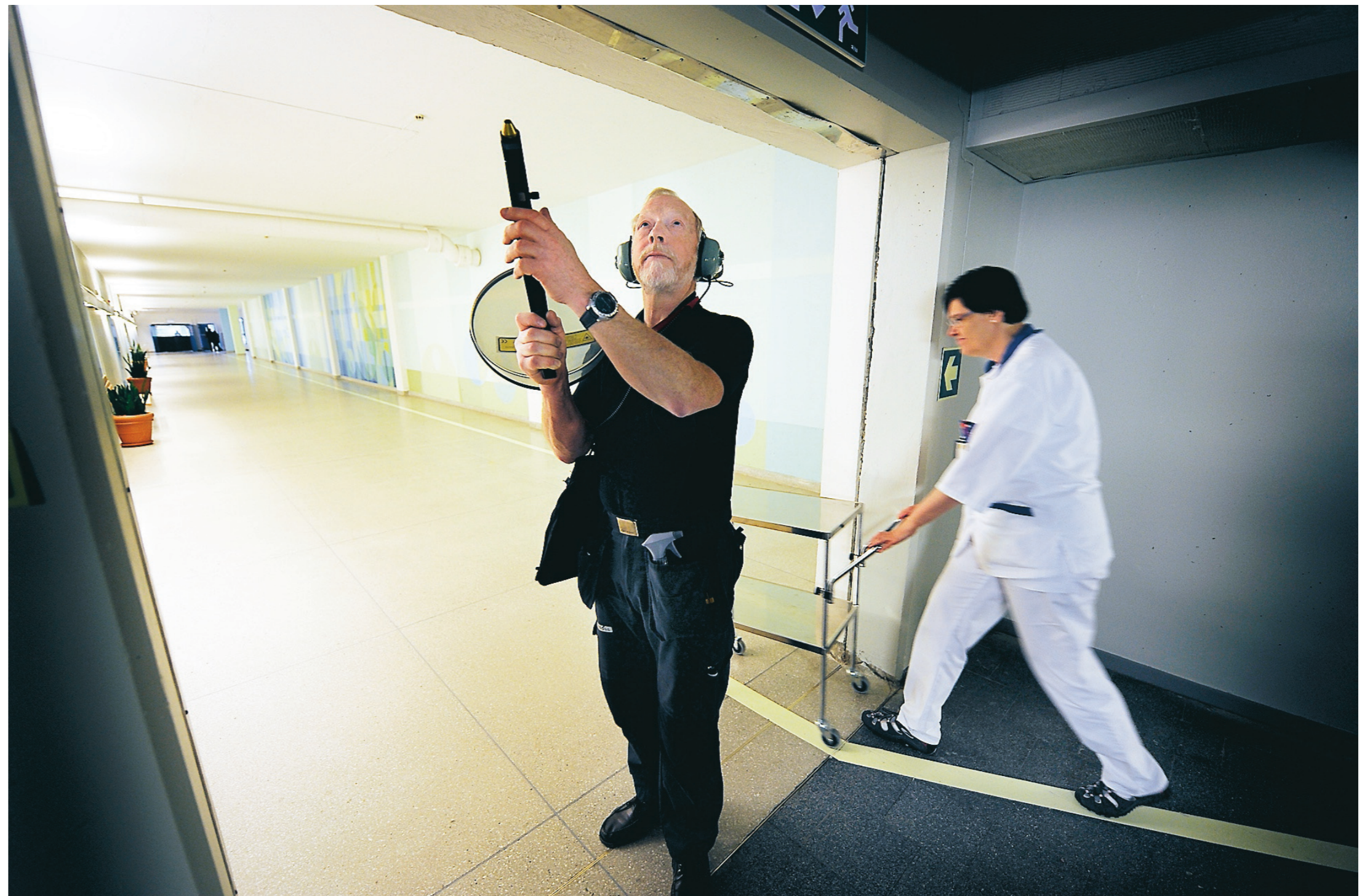
Lustgasanvändningen har ökat oförklarligt på Nyköpings lasarett det senaste året. Lustgasen är både dyr och dålig för klimatet. Konsulten Gerhard Svensson söker längs alla rör för att ta reda på om läckor är orsaken till ökningen.
